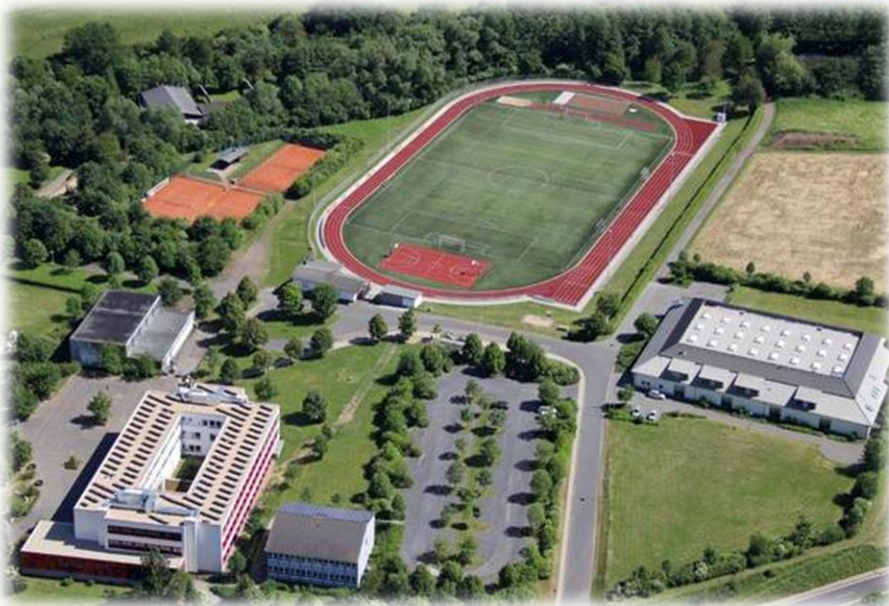
Realschule plus Niederzissen, Arweg 19, 56651 Niederzissen
